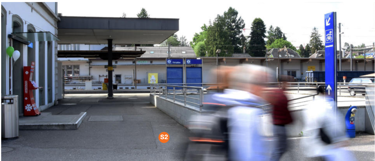
S2 Verteilpunkt, Aufgang Unterführung Seite Perron 1 (Westflügel), Stadtebene
