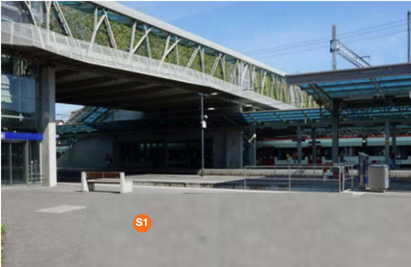
S1 Verteilpunkt, Bahnhofplatz, Passage West
