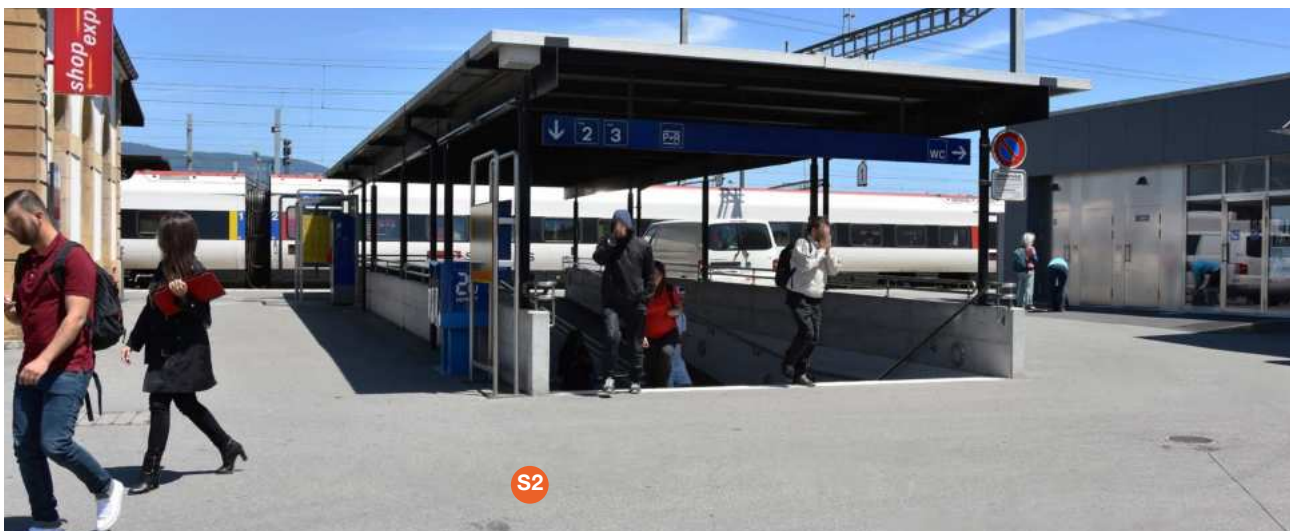
Ingresso sottopassaggio est, binario 1
