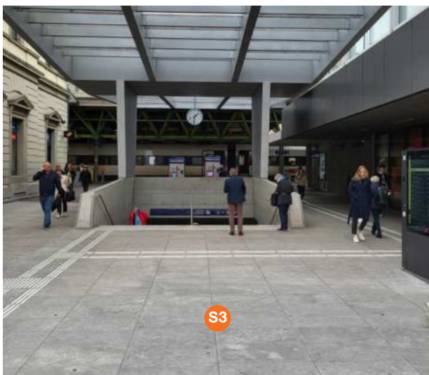
S3 Verteilpunkt, Abgang Unterführung Nord, Stadtebene
