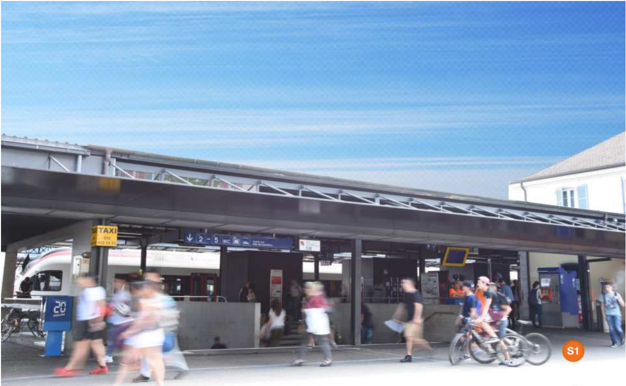
S1 Point de distribution, Ausgang Nord, Stadtebene
