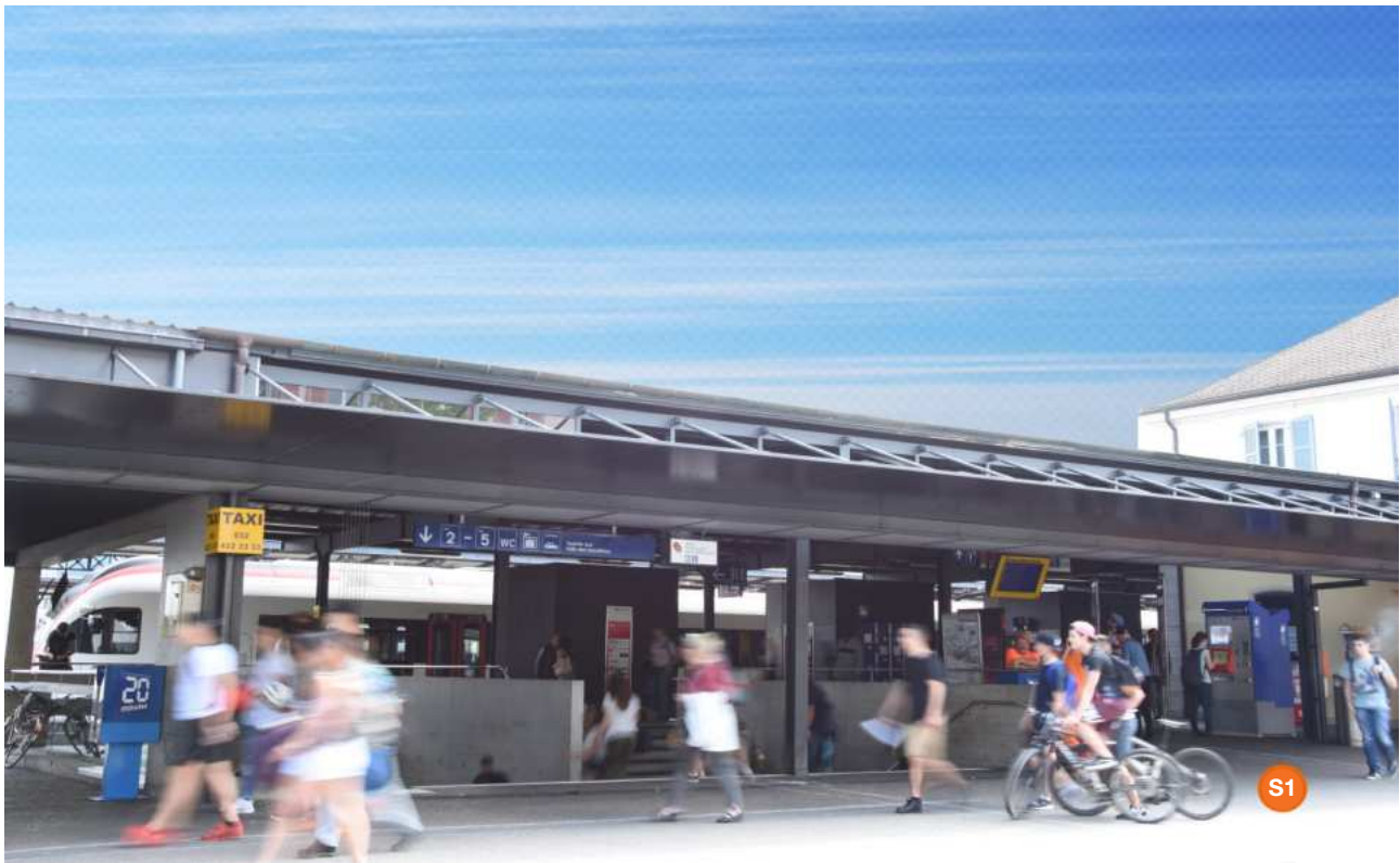
S1 Verteilpunkt, Ausgang Nord, Stadtebene
