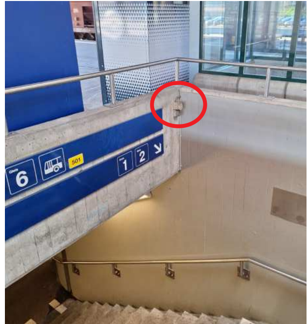
Allacciamento elettrico 230V 13A
