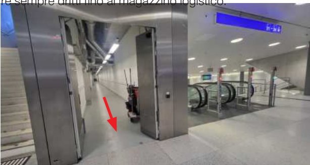
Uscita dal corridoio di consegna nel sottopassaggio Sihlquai.
