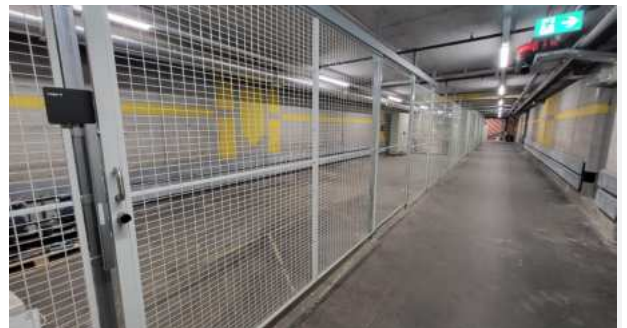
Entrepôt logistique. «Lager 3». Il y a une prise électrique dans le local de stockage.
