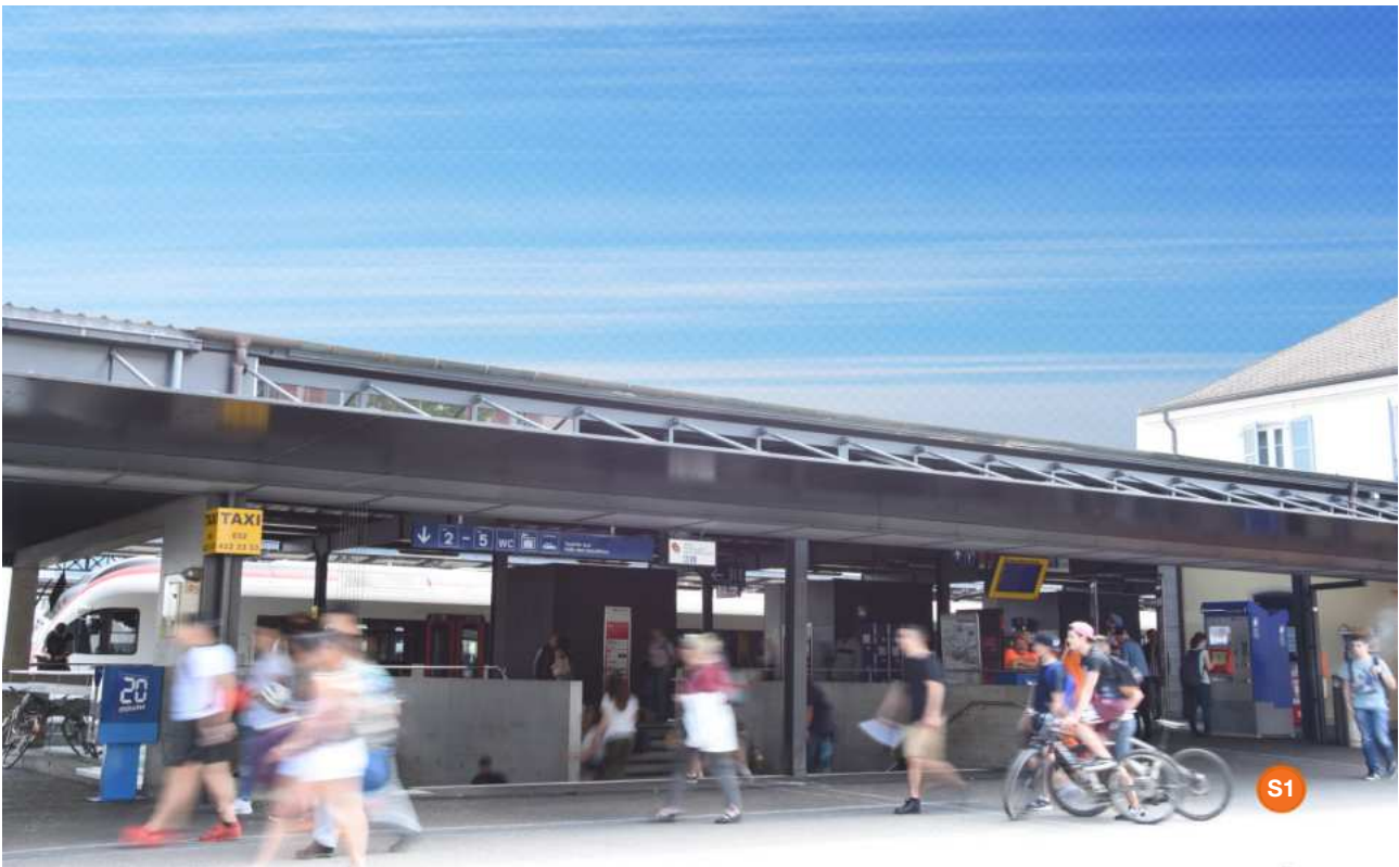
S1 Point de distribution, Ausgang Nord, Stadtebene
