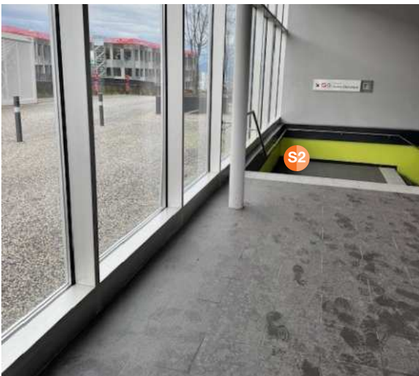
S2 2ème demi-place de distribution, station Lausanne-Croisettes,
