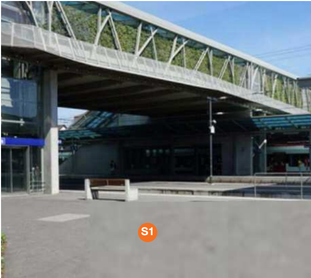
S1 Verteilpunkt, Bahnhofplatz, Passage West
