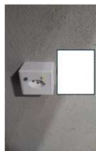
technique avec prise courant 1XT13 FI.
