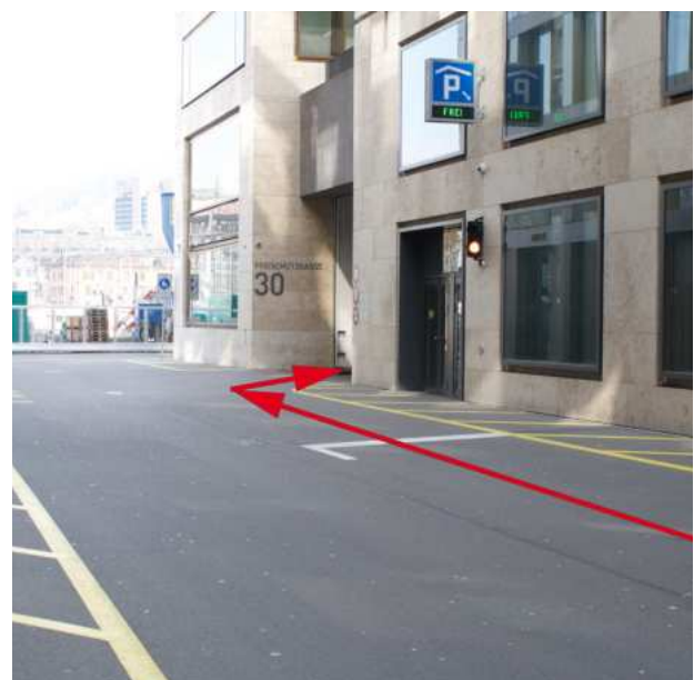
Accès au parking depuis la Freischützgasse. Hauteur maximale du véhicule à l'entrée : 4,1 m
