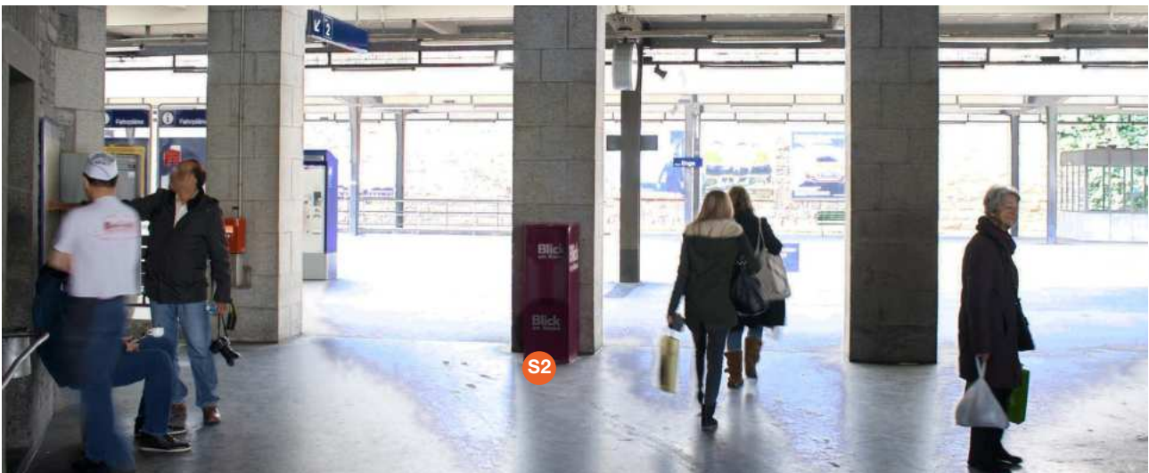
Voie 1, niveau ville
