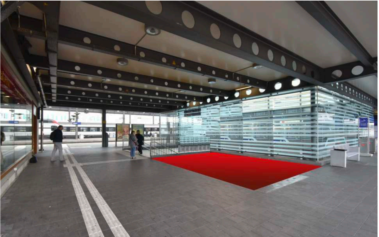
P1 Stand promozionale, davanti alla panetteria Hug, a sinistra e a destra delle scale che scendono, 6,2 \times 5,2 = 32\text{m}^2
