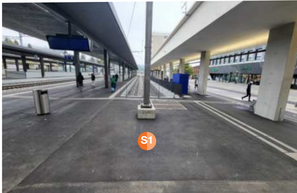
S1 Piazza della stazione lato nord, 1. mezzo punto di distribuzione con 2 promotori ciascuno
