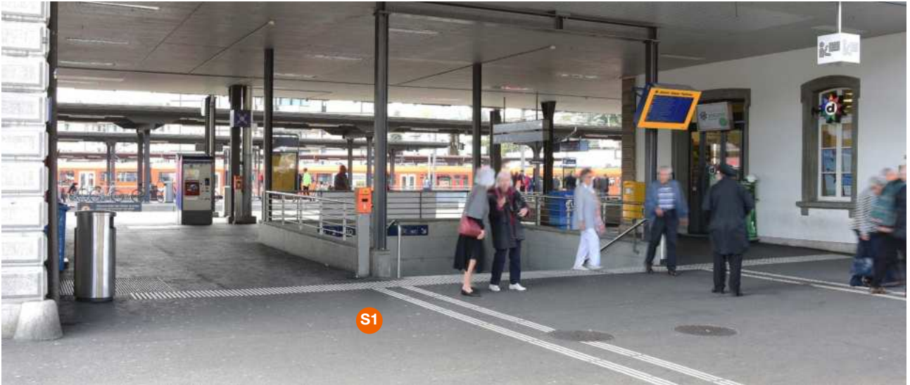
Accès passage souterrain côté Bahnhofplatz, niveau ville
