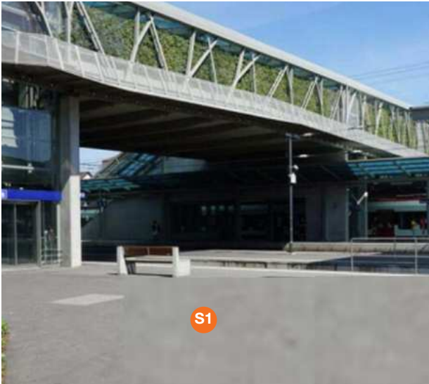
S1 Bahnhofplatz, Passage West
