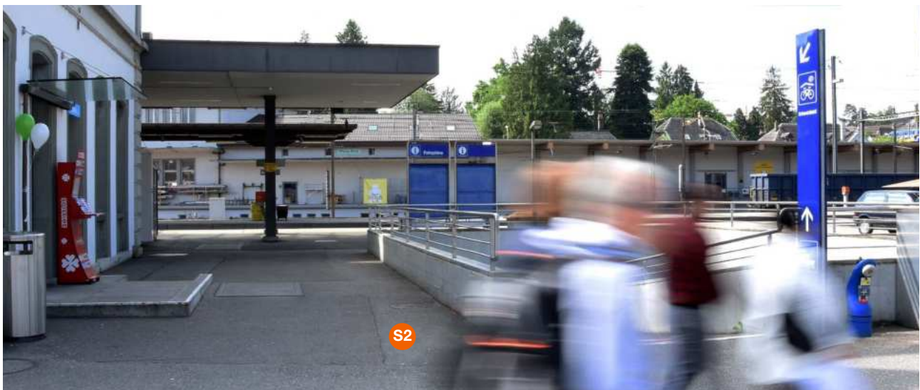
Accès passage souterrain côté perron 1 (aile ouest), niveau ville
