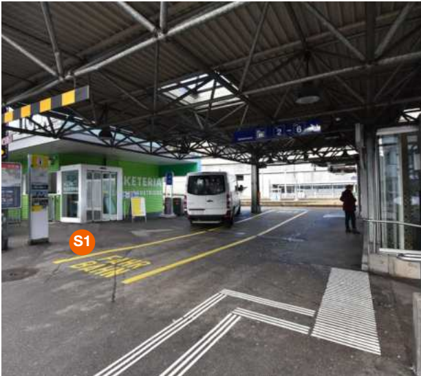
Place de la Gare ouest
