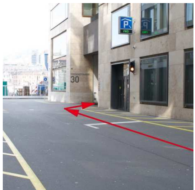
Accès au parking depuis la Freischützgasse. Hauteur maximale du véhicule à l'entrée : 4,1 m
