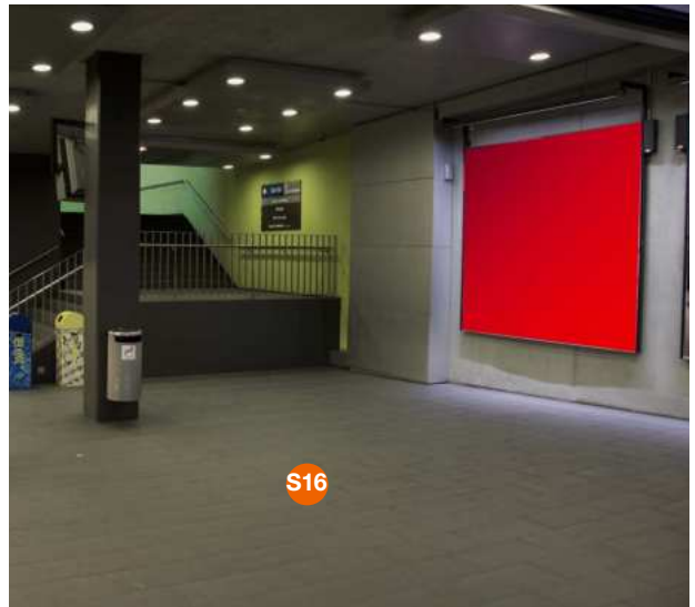
Station Croisettes, à droite des escaliers, devant espace « P3 »
